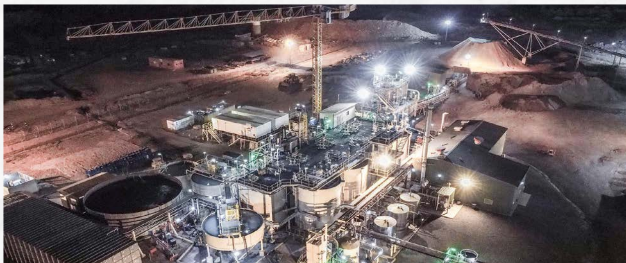
Usine de traitement de la mine de Yaramoko ▶
