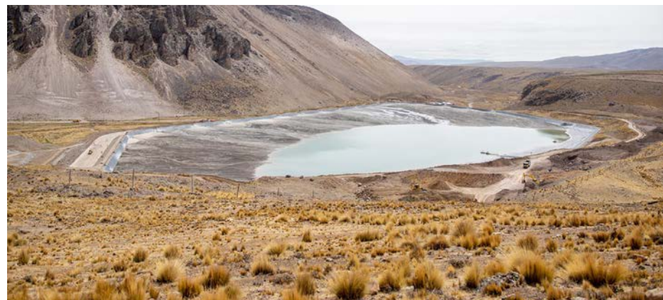
▲ Installation de stockage des résidus de la mine de Caylloma
