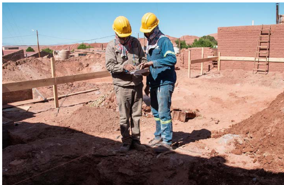
▲ Personal de construcción del Centro de Salud de Lindero
